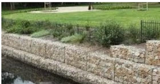
Рис. 3. Габионная конструкция
